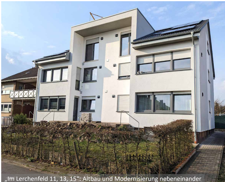
„Im Lerchenfeld 11, 13, 15“: Altbau und Modernisierung nebeneinander
